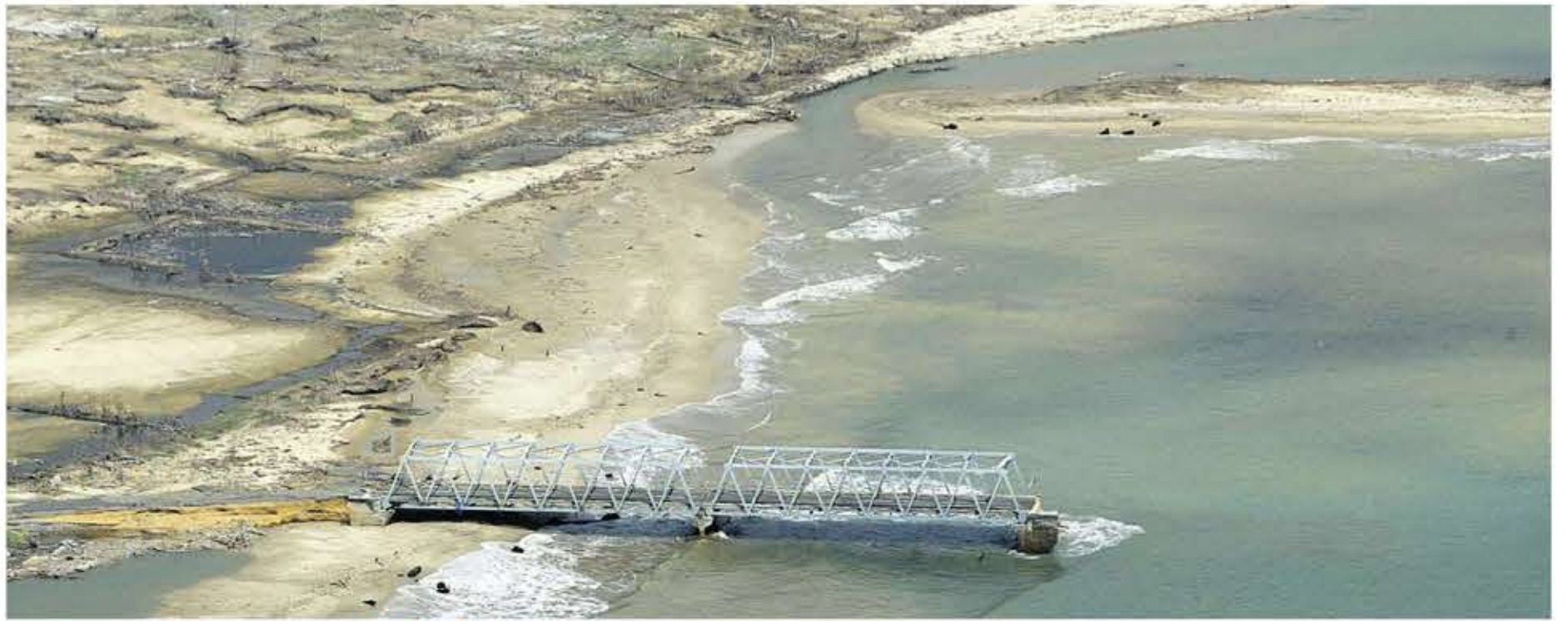
Kahle Küste: Die zerstörte Brücke an der Westküste der Provinz Aceh zeugt von der Wucht der Flutwelle. Indonesien will den Bau von Häusern entlang der Küstenlinie stärker reglementieren und zugleich die Mangrovenwälder aufforsten, die als natürliche Barriere gegen die Fluten wirken.
