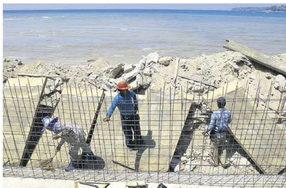
Mit Betonwällen bewehren thailändische Arbeiter den Kamala-Strand bei Phuket, der vom Tsunami am 26. Dezember 2004 schwer verwüstet worden war.
