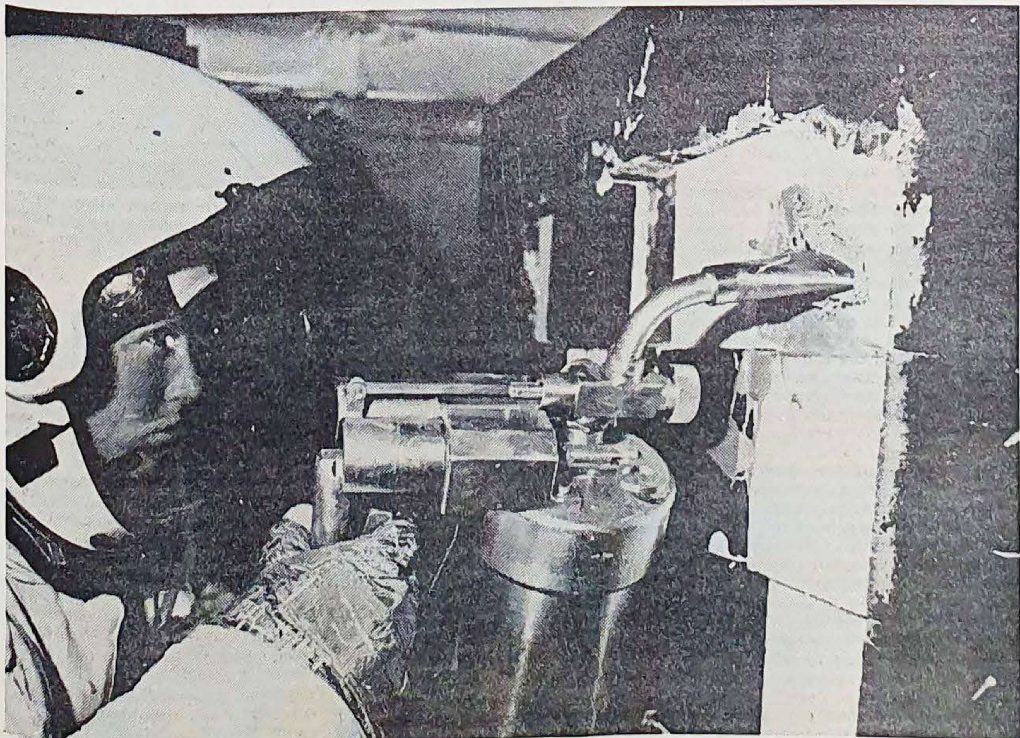
Die Astronautin Anna L. Fisher repariert hier eine beschädigte Wärmeschutzplatte. Dieses wirklichkeitsnahe Experiment fand erstmals anfangs Juli 1980 an Bord eines Flugzeuges vom Typ Boeing KC-135 statt, in dem als Folge eines speziellen Kurvenfluges für etwa 30 s schwerkraftsfreie Bedingungen herrschen.
