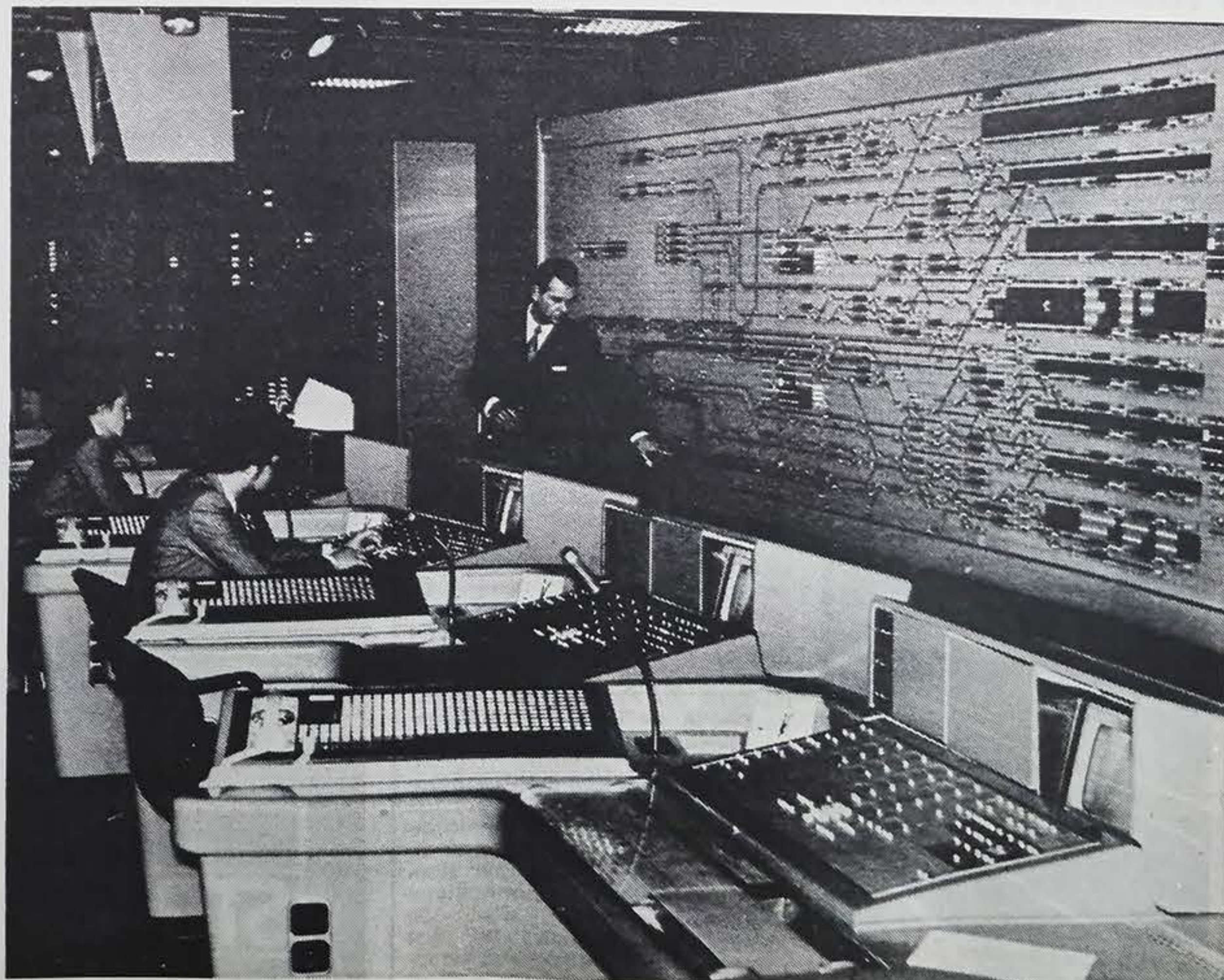
Zentralstellwerke mit modernsten technischen Einrichtungen, wie hier das neue Drucktasten-Stellwerk im Stuttgarter Hauptbahnhof, beschleunigen den Betriebsablauf, steigern die Kapazität vorhandener Gleisanlagen und kommen mit wesentlich weniger Bedienungspersonal aus als alte Anlagen.
